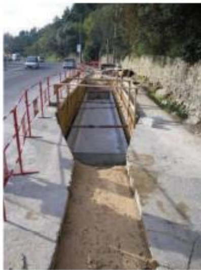
Photo 9 : Illustration d'une chambre de jonction d'une liaison souterraine d'un seul circuit 225 000 volts (RTE)
