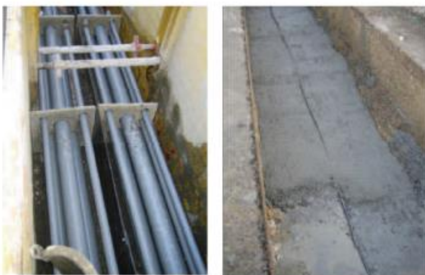
Photo 8 : Illustration d'une liaison souterraine à deux circuits sous voirie (RTE)
