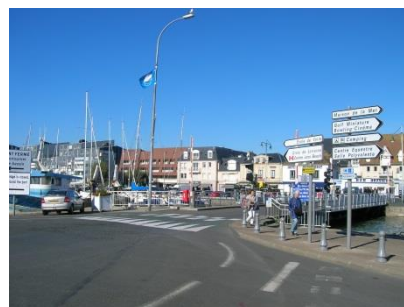
Pont levant et aménagement routier
