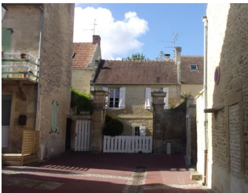
Bâti ancien face à l'église
