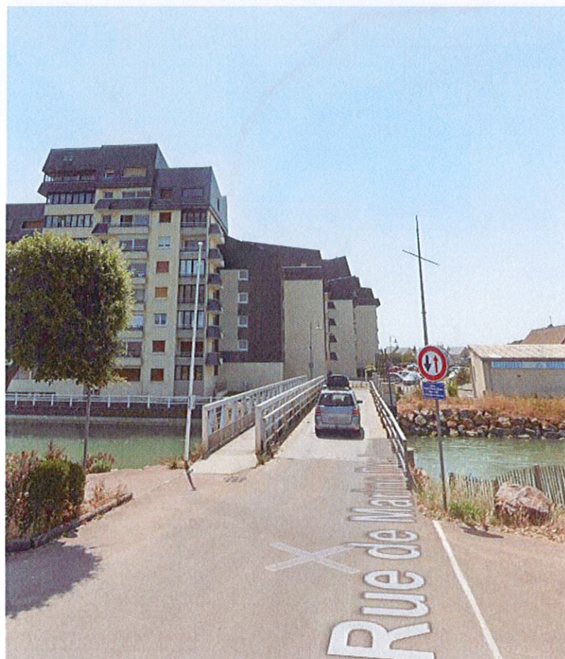
Vue du Pont Marine Dunkerque
