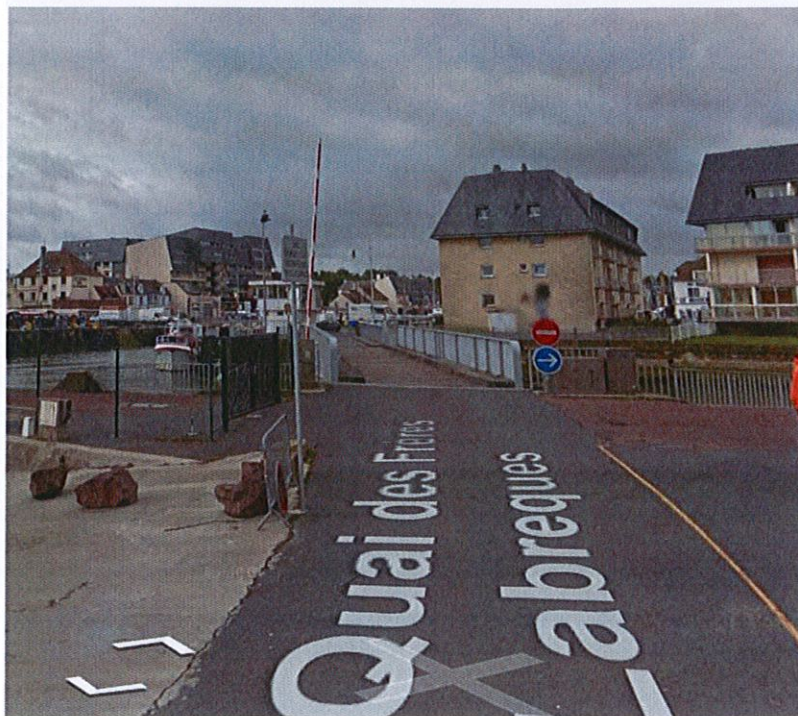
Vue du Pont Quai des Frères Labrèque
